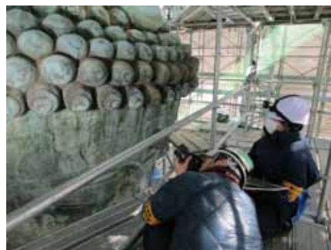
図1 損傷状態・技法調査
